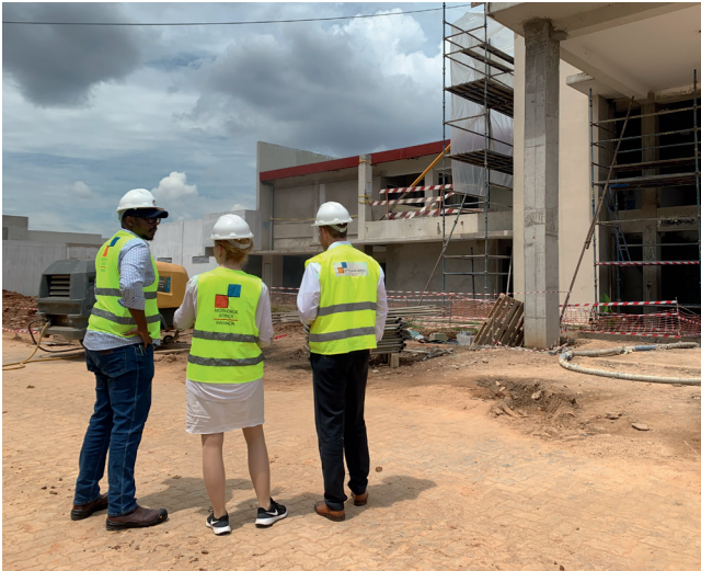
Besuch einer Baustelle eines ruandischen Bauunternehmens, Copyright: Lena Pahlenberg
